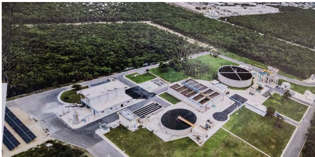
Figura 3 Vista general PTAR Sur
