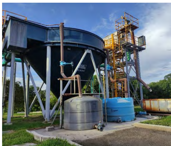
Figura 9 Cárcamo final (Sur) y unidad de pretratamiento con criba fina de tambor y cono
