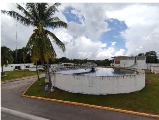
Figura 9 Clarificador secundario y vista cárcamo de recirculación de lodos
