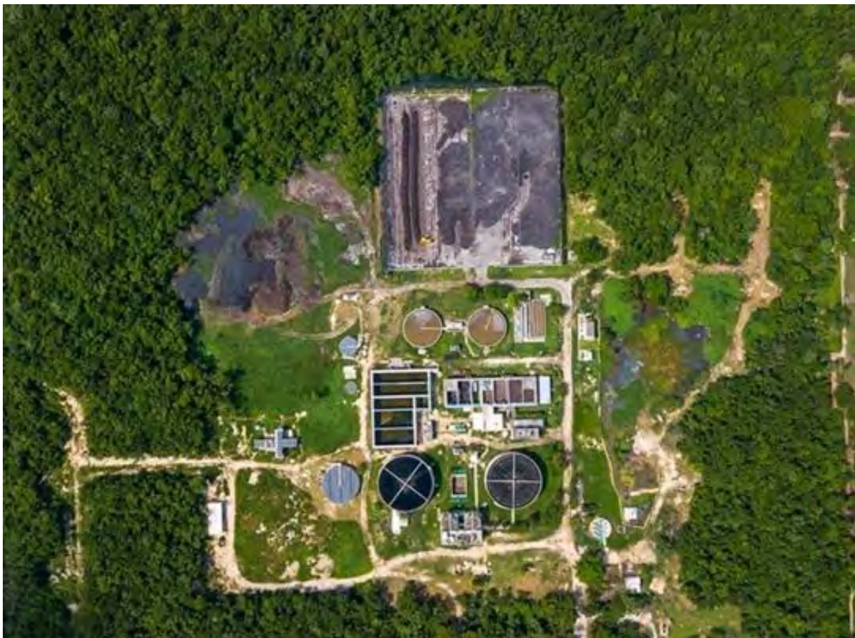
Figura 22 Vista actual de la PTAR Norponiente
