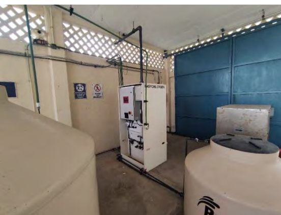
Figura 13 Equipo de Generación de Hipoclorito en Sitio (Fuera de Servicio) 1ª Etapa
