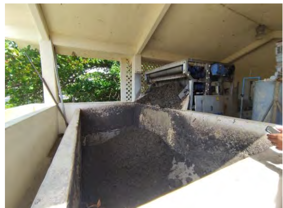
Figura 16 Caseta de Desaguado de Lodo, Preparador de Polímero y Filtro Banda en Operación de Desaguado
