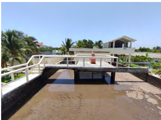
Figura 15 Digestor de lodo en fase de decantación y bombas de lodo digerido a desaguado
