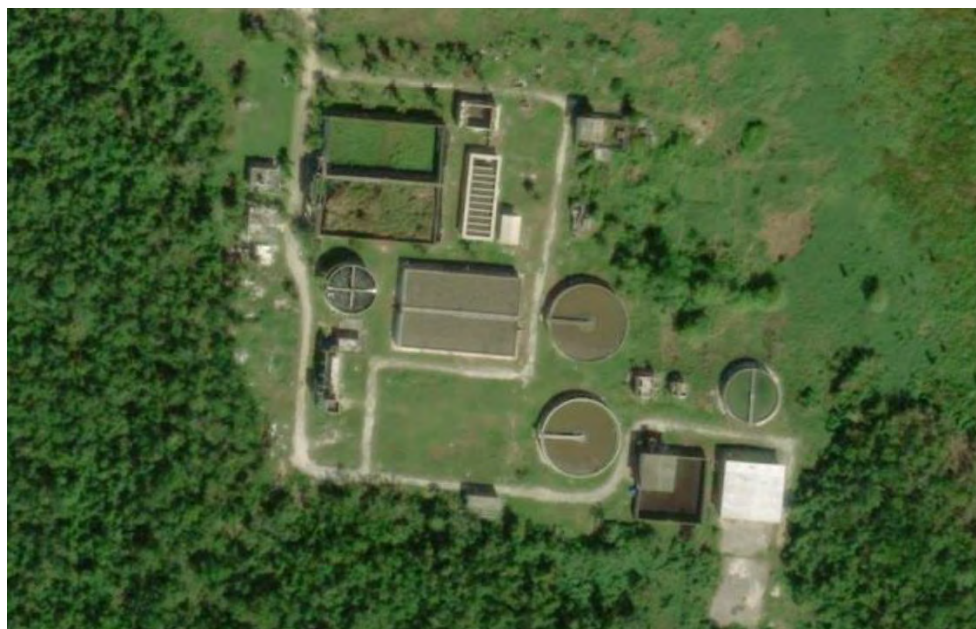
Figura 1 Vista Aérea PTAR San Miguelito en Cozumel
