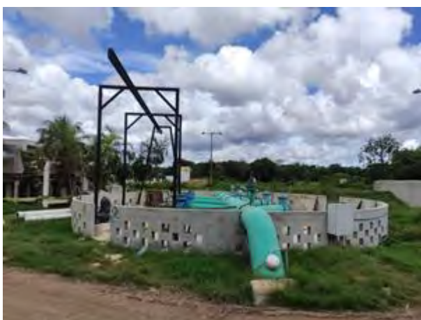
Figura 3 Cárcamo final de agua cruda e hidrocribas en la línea de infiltración de excedentes de agua cruda
