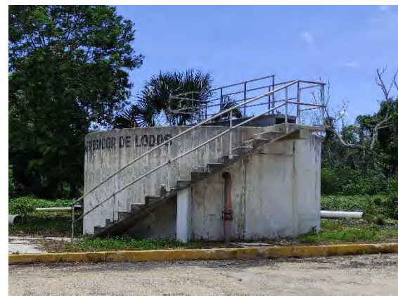
Figura 16 Espesador de lodos
