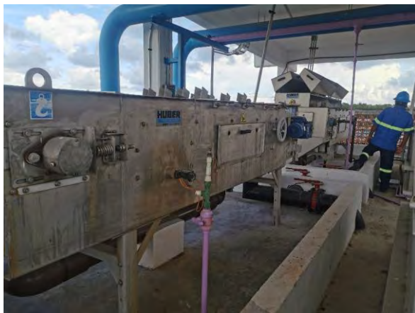
Figura 12 Mesa de Espesado y Centrífuga de Lodos
