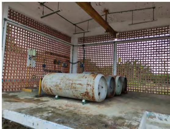
Figura 11 Caseta de dosificación de cloro y detalle de techo con grietas y desprendimiento de enjarre
