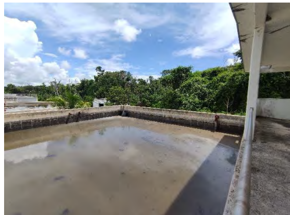
Figura 15 Digestor aerobio de lodos
