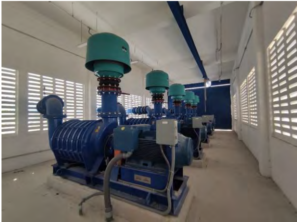
Figura 6 Sopladores de Reactor de Lodos Activados
