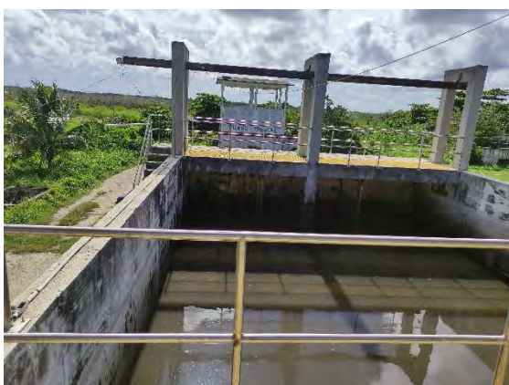
Figura 15 Cárcamo de agua para reúso y medidor de agua para reúso (inundado)
