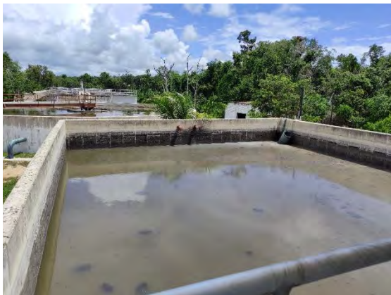
Figura 15 Digestor aerobio de lodos
