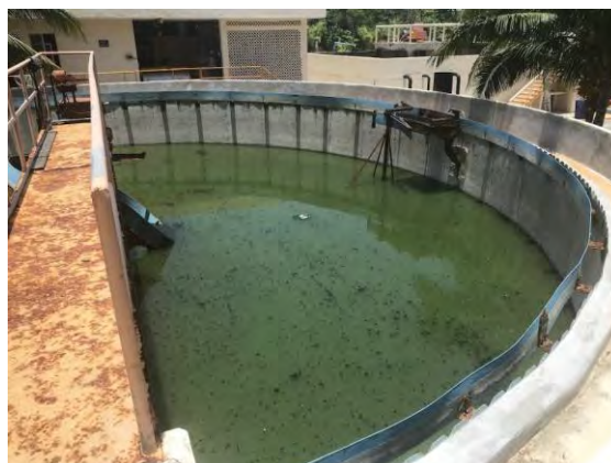
Figura 10 Clarificador secundario 1 y clarificador secundario 2, fuera de operación
