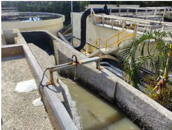
Figura 6 Canal Parshall y Caja Distribuidora de Agua Cruda
