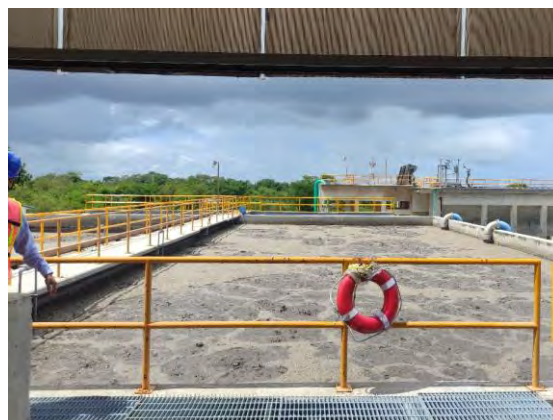
Figura 12 Mesa de Espesado de Lodos y Digestor Aerobio de Lodos
