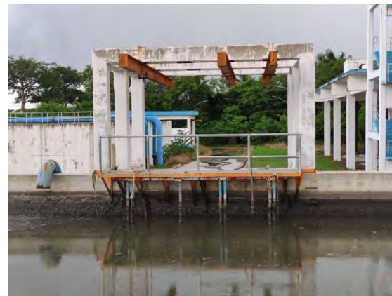
Figura 5 Estructura para izaje y bombas de tanque equalizador
