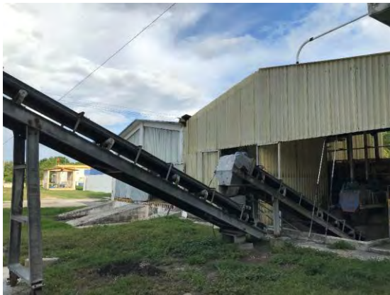
Figura 15 Banda transportadora de lodo desaguado; cárcamo de bombeo agua de rechazo de desaguado
