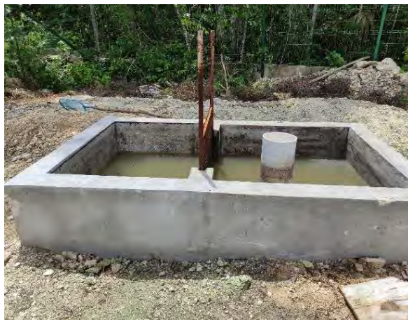
Figura 25 Pozos de infiltración PTAR Bicentenario
