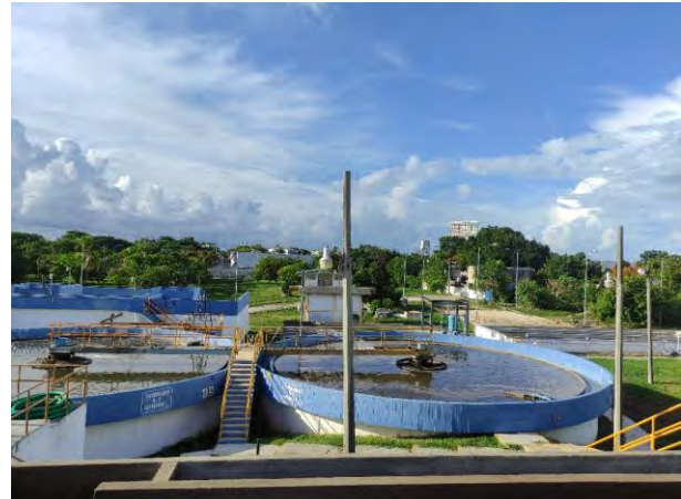
Figura 5 Licor mezclado efluente de reactor de lodos activados; clarificadores secundarios 1 y 2
