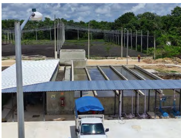
Figura 9 Tanque de contacto de cloro; caseta de cloración y scrubber para neutralización de fugas de cloro
