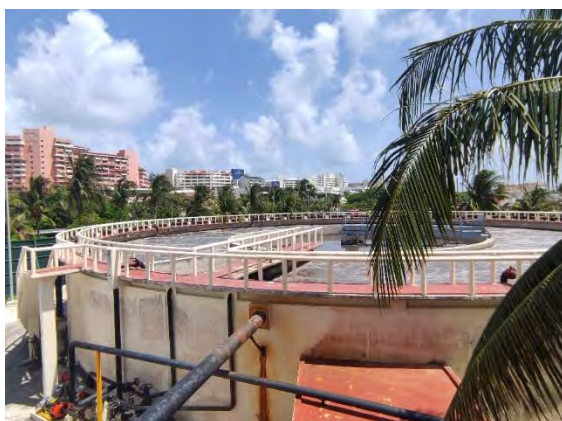
Figura 18 Reactor de Lodos Activados y Clarificador Secundario 2ª Etapa
