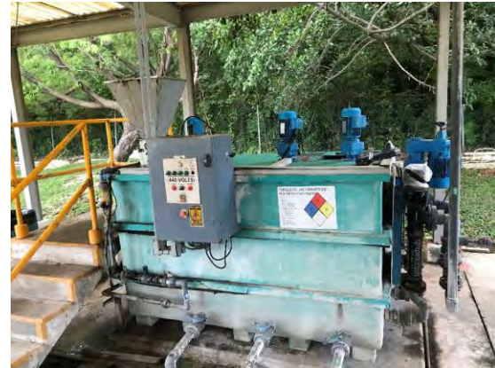
Figura 14 Filtro banda para desaguado de lodo; sistema de preparación de polímero
