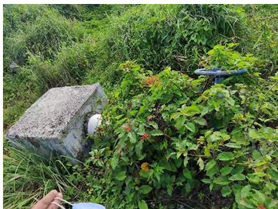
Figura 14 Pozo de infiltración cubierto de maleza
