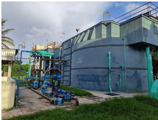
Figura 11 Bombas de recirculación y purga de lodo químico; línea efluente del TPQ a tanque de contacto de cloro
