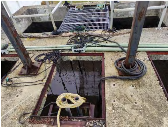
Figura 15 Detalle de instalación en cárcamo de recirculación de lodos (izquierda) y cárcamo de natas (derecha)
