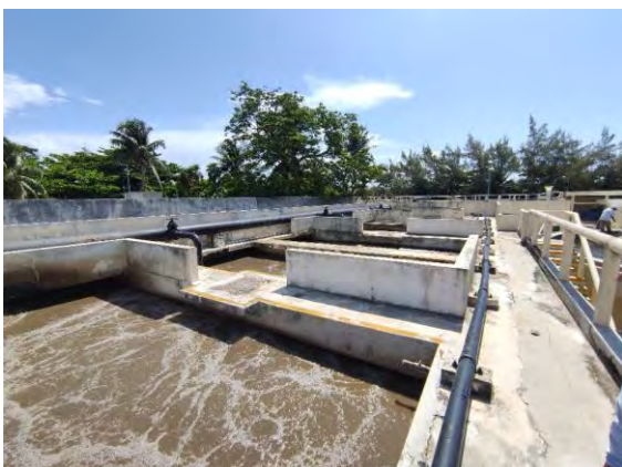
Figura 9 Reactor de Lodos Activados Tipo II
