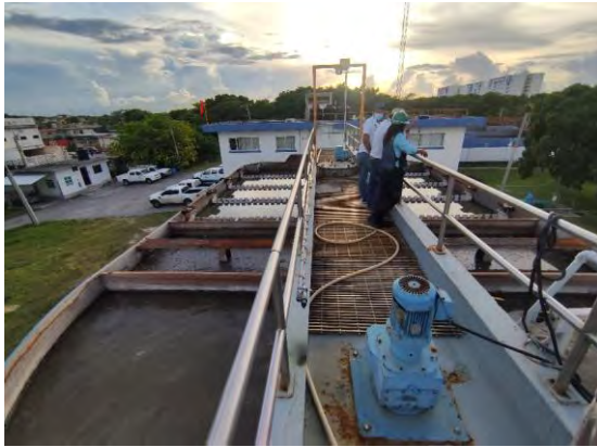
Figura 10 Cámara de floculación y clarificador lamelar del TPQ
