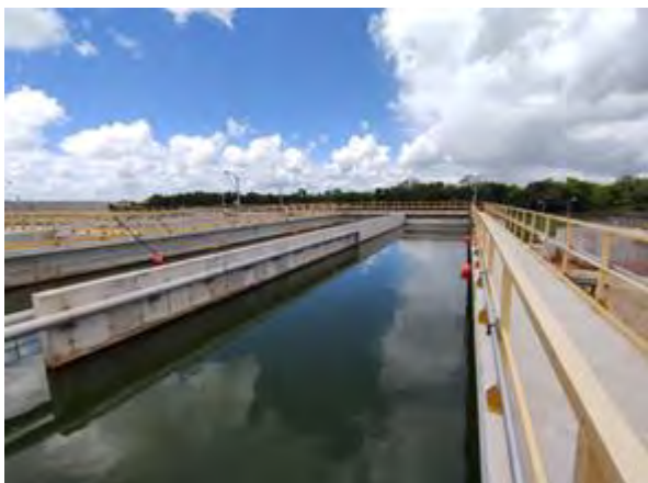
Figura 7 Sección anóxica del reactor de lodos activados y cabezal de aeración del reactor de lodos activados
