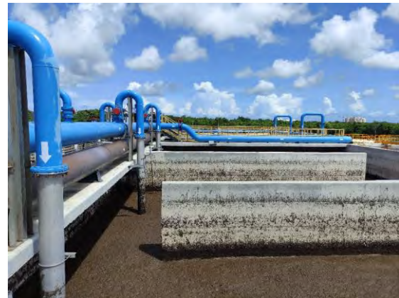
Figura 12 Digestor Aerobio de Lodos en celda de Reactor de Lodos Activados
