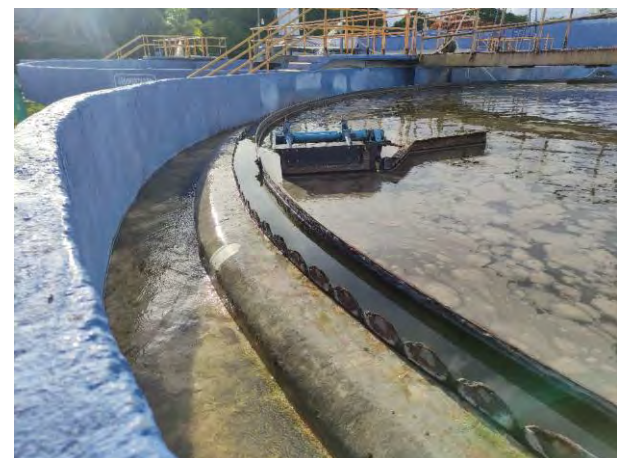
Figura 6 Clarificador secundario 2 y 3, cárcamo de recirculación y purga de lodo; agua clarificada efluente
