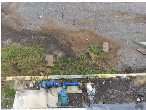
Figura 17 Bomba de lodo digerido (fuera de operación) y espesador gravitacional de lodo
