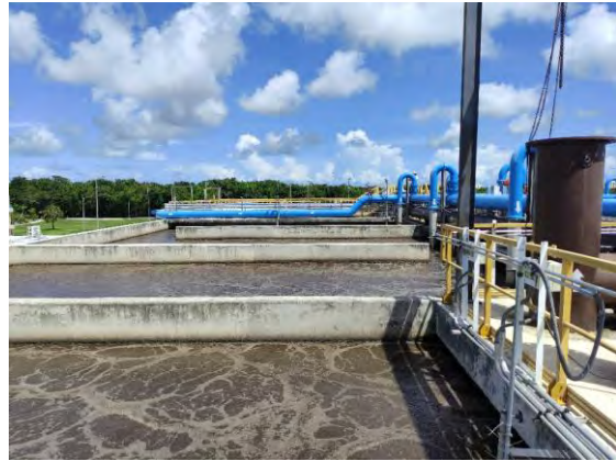
Figura 7 Reactor de Lodos Activados Zona Anóxica (Izquierda) y Zona Aerobia (Derecha)
