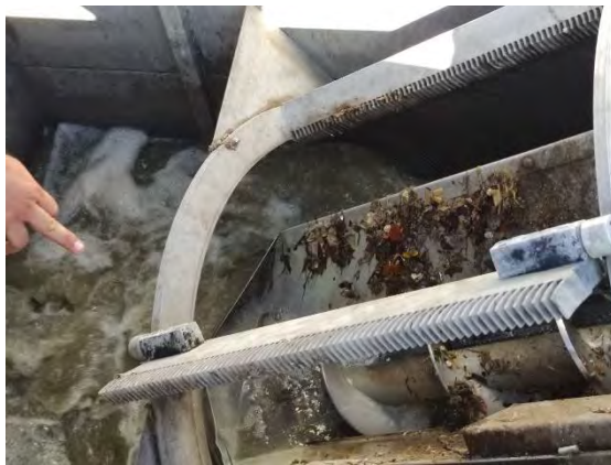
Figura 6 Criba rotatoria y descarga de arenas
