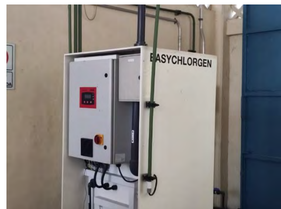
Figura 13 Equipo de Generación de Hipoclorito en Sitio (Fuera de Servicio) 1ª Etapa
