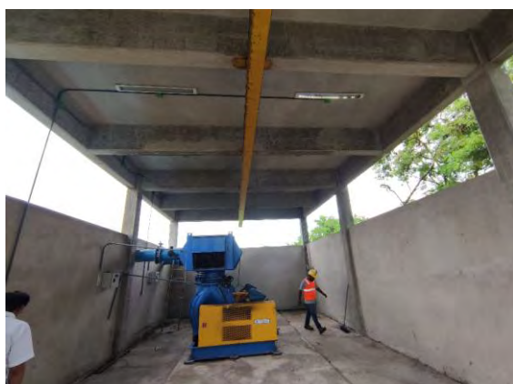
Figura 14 Caseta de sopladores de reactor de lodos activados
