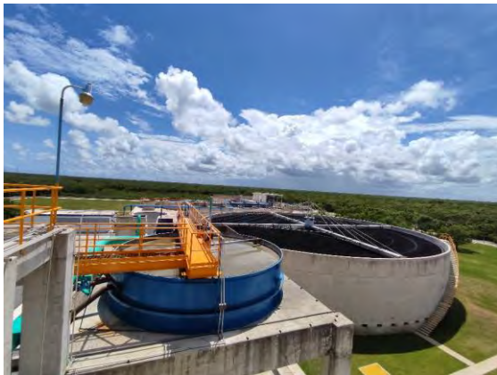
Figura 5 Cono Desarenador y Filtro Rociador y Vista General de PTAR
