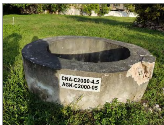
Figura 21 Pozos de infiltración PTAR Caribe
