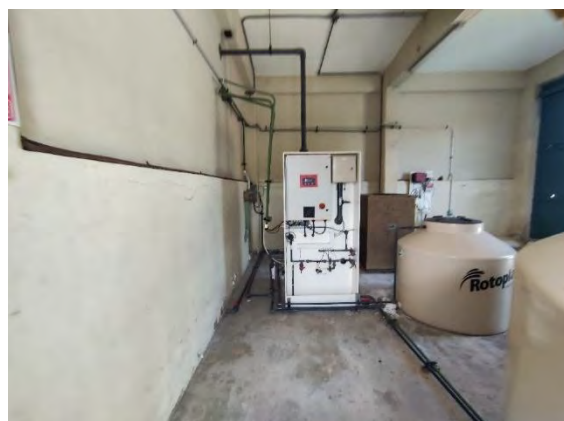
Figura 21 Sistema de Generación de Hipoclorito In Situ 2ª Etapa
