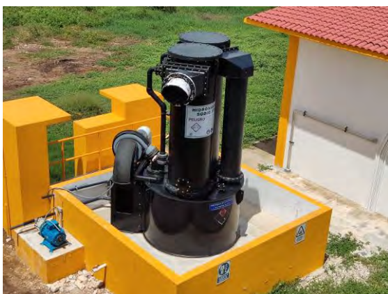
Figura 11 Lavador de Gases (Scrubber) y Batería de Bombas de Servicio
