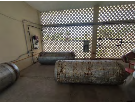
Figura 12 Tanques de Cloro y Caseta de Dosificación 1ª Etapa
