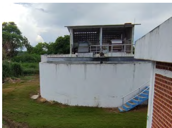
Figura 17 Bomba de lodo digerido (fuera de operación) y espesador gravitacional de lodo
