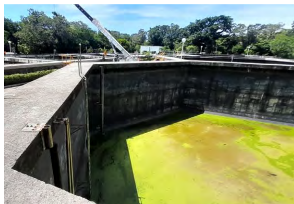
Figura 5 Reactores SBR 2a Etapa, Equipado y Sin Equipar
