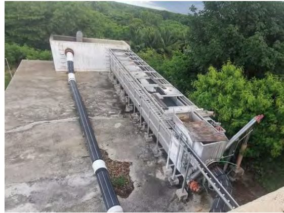
Figura 7 Cribado mecánico y equipo pretratamiento compacto Ro5 en plataforma
