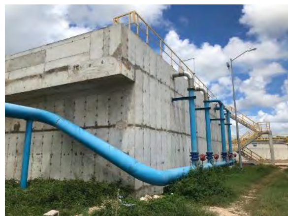
Figura 7 Sección anóxica del reactor de lodos activados y cabezal de aeración del reactor de lodos activados
