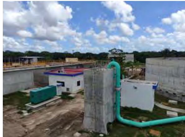
Figura 6 Cárcamo de elevación y recirculación al filtro rociador; Caja distribuidora "B" y by pass agua pretratada a lodos activados
