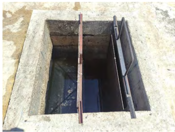
Figura 11 Tanque de Contacto de Cloro Tapado, Rejillas de Retención de Natas
