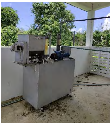
Figura 17 Equipo preparador de polímero y filtro banda fuera de operación
