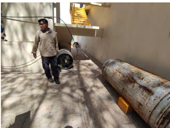
Figura 12 Tanques de Gas Cloro y Dosificador, Instalados a la Intemperie
