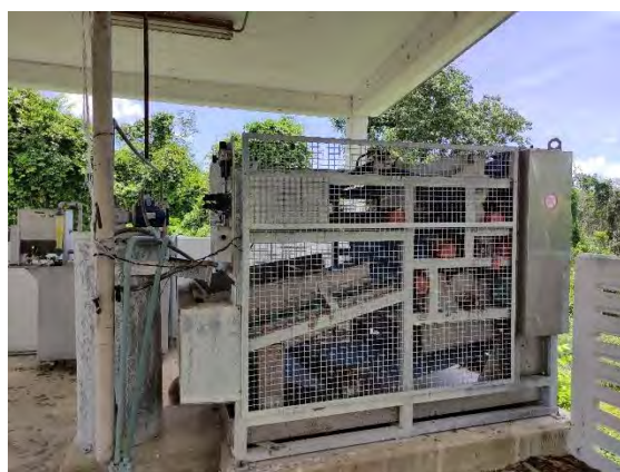
Figura 17 Equipo preparador de polímero y filtro banda fuera de operación
