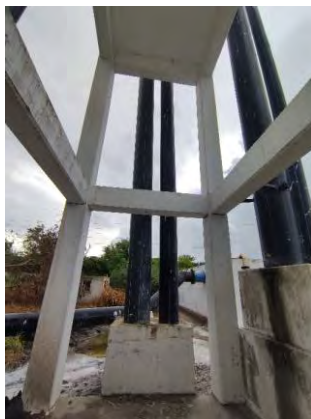
Figura 6 Cabezal de descarga de tanque equalizador y línea de demasías
