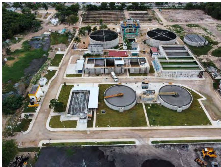
Figura 1 Vista General PTAR Norponiente I
