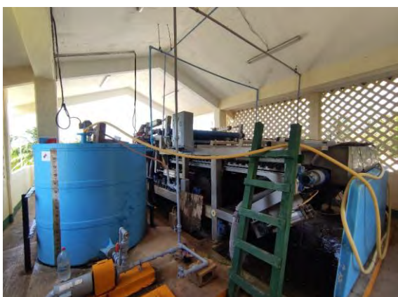
Figura 17 Preparador de Polímero con Filtro Banda y Caseta de Desaguado de Lodo
