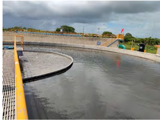
Figura 9 Clarificador Secundario
