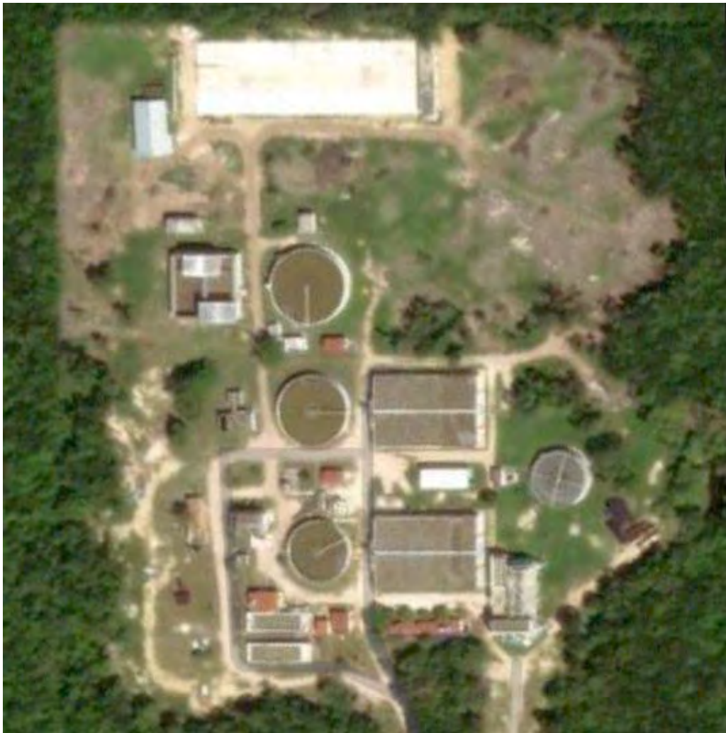
Figura 21 Vista actual de la PTAR Saas Tun Há
