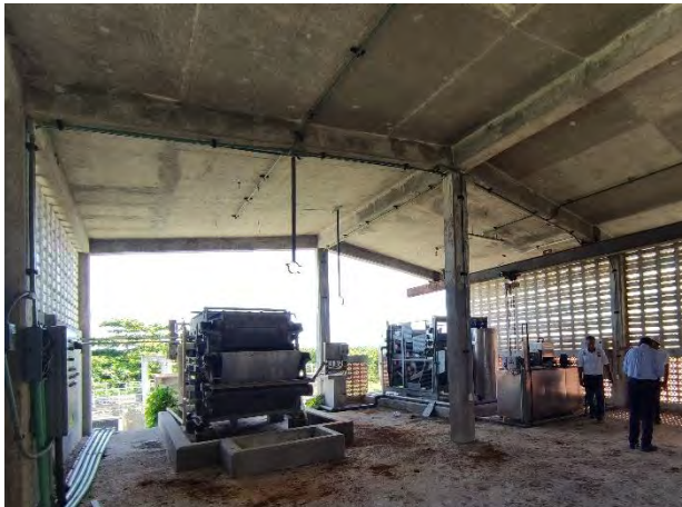
Figura 18 Aspecto de la planta alta de la caseta de desaguado de lodos con equipos fuera de operación.
