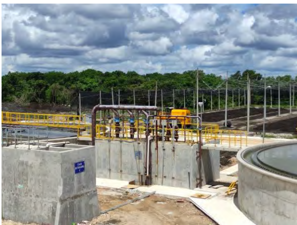
Figura 12 Cárcamo de purga y recirculación de lodo; mesa de espesado de purga de lodo secundario
