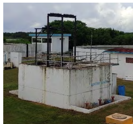
Figura 9 Clarificador secundario y vista cárcamo de recirculación de lodos
