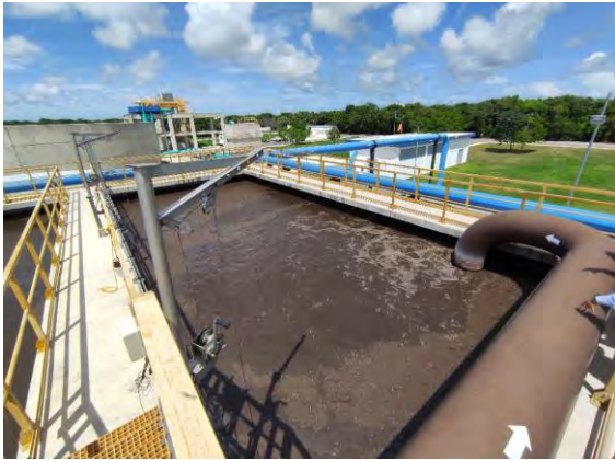
Figura 7 Reactor de Lodos Activados Zona Anóxica (Izquierda) y Zona Aerobia (Derecha)
