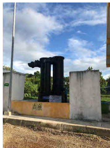
Figura 7 Tanque de contacto de cloro y caseta de cloración; scrubber para neutralización de fugas de cloro
