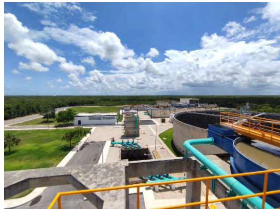
Figura 5 Cono Desarenador y Filtro Rociador y Vista General de PTAR
