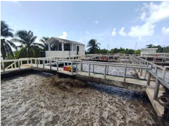
Figura 9 Reactor de Lodos Activados Aireación Superficial 1ª Etapa
