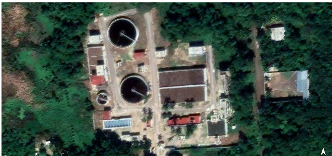
Figura 1 Vista Aérea PTAR Centenario de Chetumal
