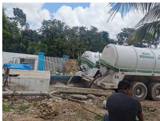
Figura 4 Plataforma de pretratamiento y cárcamo de recepción de pipas
