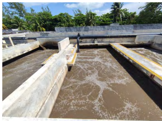
Figura 9 Reactor de Lodos Activados Tipo II
