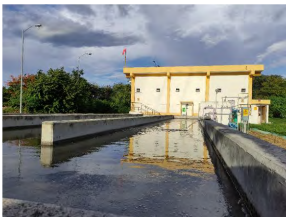
Figura 7 Tanque de contacto de cloro y caseta de cloración; scrubber para neutralización de fugas de cloro
