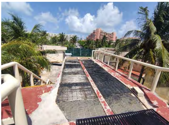
Figura 17 Desarenador Horizontal y Distribución a Reactores de Lodos activados 2ª Etapa
