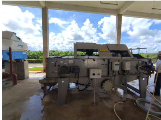
Figura 11 Caseta de Lodos y Mesa Espesadora
