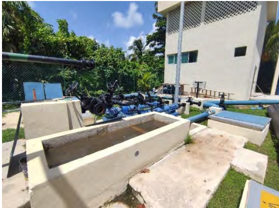
Figura 14 Pozo de infiltración de agua tratada y Bombas para Reúso 1ª Etapa
