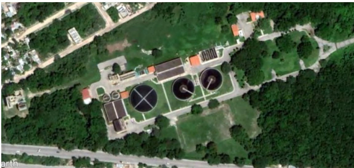
Figura 1 Vista Aérea PTAR Norte
