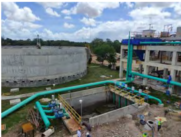
Figura 6 Cárcamo de elevación y recirculación al filtro rociador; Caja distribuidora "B" y by pass agua pretratada a lodos activados
