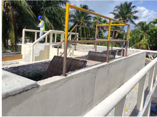
Figura 5 Vertedores en Desarenación Horizontal y Cribado Manual
