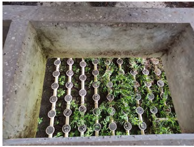
Figura 17 Digestor aerobio de lodos abandonado
