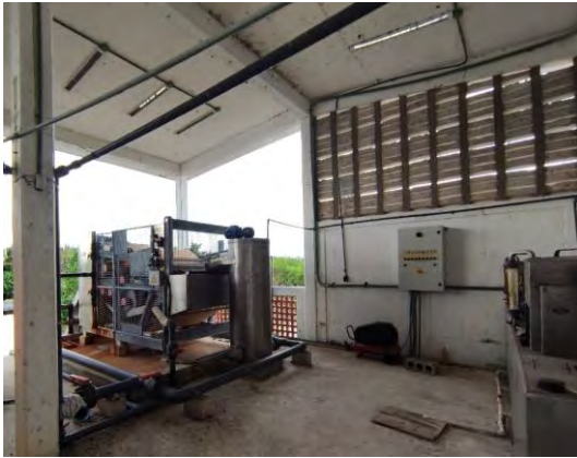
Figura 18 Filtro banda y preparador de polímero
