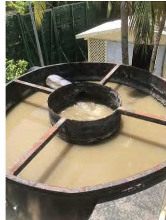
Figura 4 Cárcamo final de agua cruda y vista superior del desarenador
