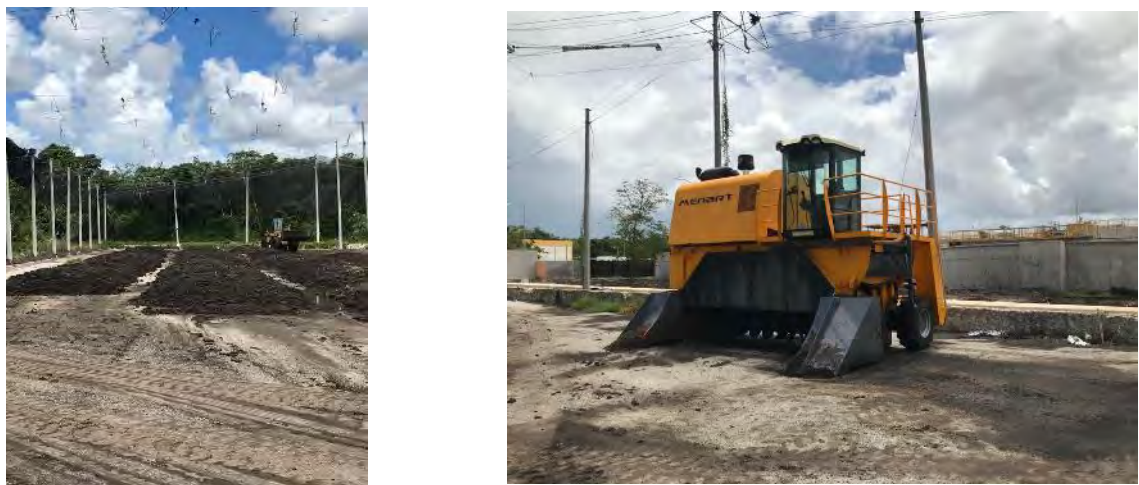
Figura 15 Patio de secado adicional de lodo desaguado; equipo para volteo y aereación de trincheras de lodo
