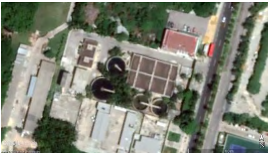
Figura 1 Vista Aérea PTAR El Rey
