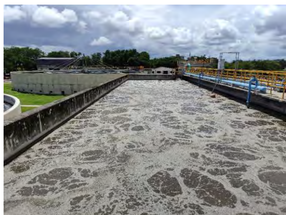
Figura 8 Reactor de Lodos Activados y Tubería Influyente Reactor
