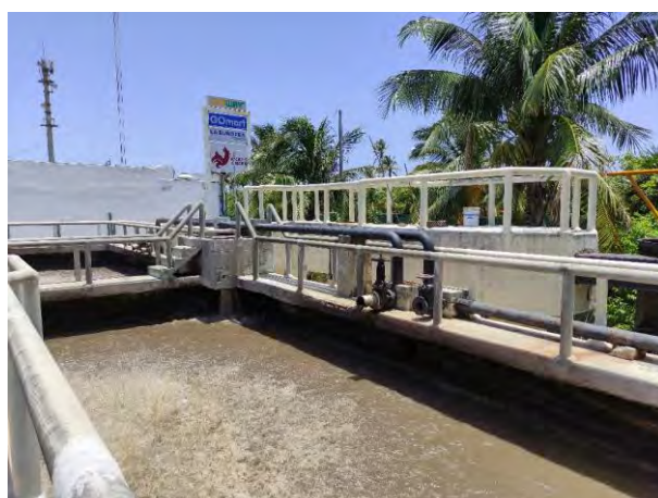
Figura 9 Bombas de recirculación y purga de lodo secundario, línea de recirculación de lodo a sección inicial del reactor
