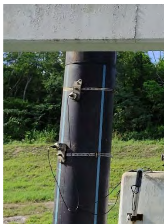
Figura 4 Carátula de medidor de caudal influente (fuera de servicio) y transductores para medición ultrasónica
