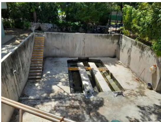
Figura 3 Cribado grueso manual y cárcamo de agua pretratada
