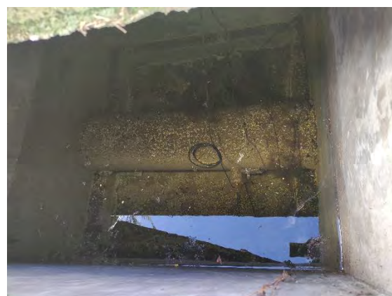
Figura 15 Cárcamo de agua para reúso y medidor de agua para reúso (inundado)
