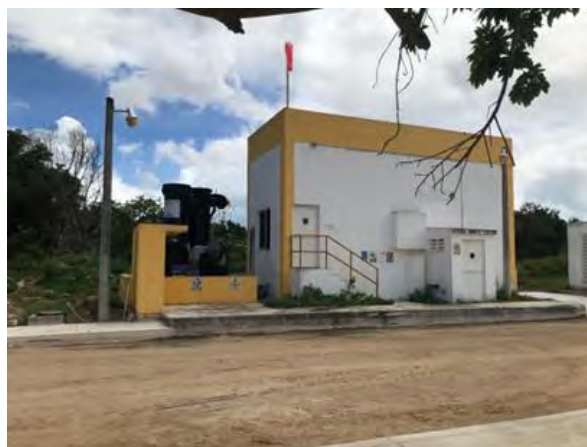
Figura 9 Tanque de contacto de cloro; caseta de cloración y scrubber para neutralización de fugas de cloro
