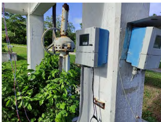
Figura 4 Carátula de medidor de caudal influente (fuera de servicio) y transductores para medición ultrasónica
