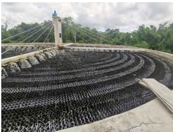
Figura 8 Filtro rociador con brazo distribuidor sin movimiento y cárcamo de elevación de agua de filtro rociador
