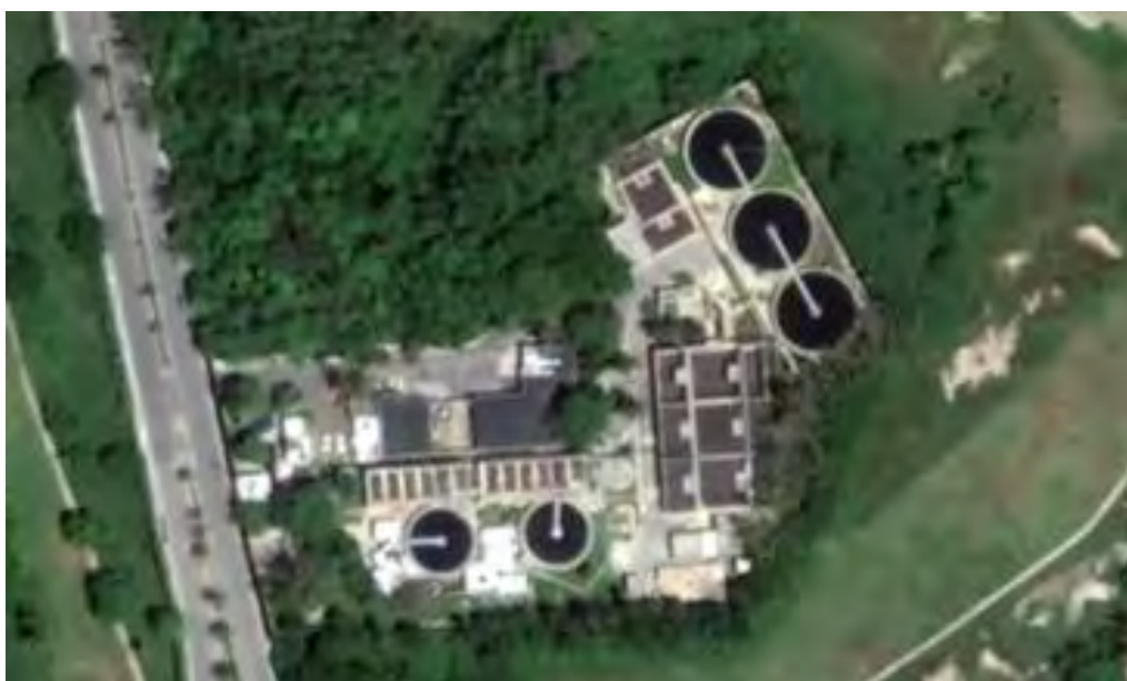
Figura 24 Vista actual de la PTAR Pok Ta Pok
