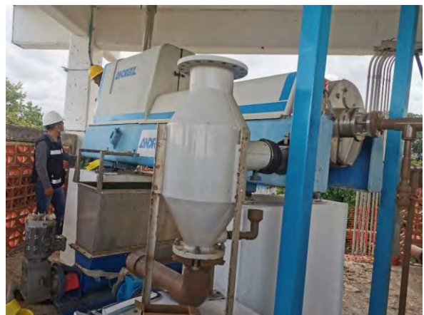
Figura 12 Mesa de Espesado y Centrífuga de Lodos
