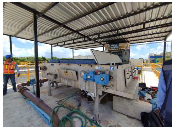
Figura 12 Cárcamo de purga y recirculación de lodo; mesa de espesado de purga de lodo secundario
