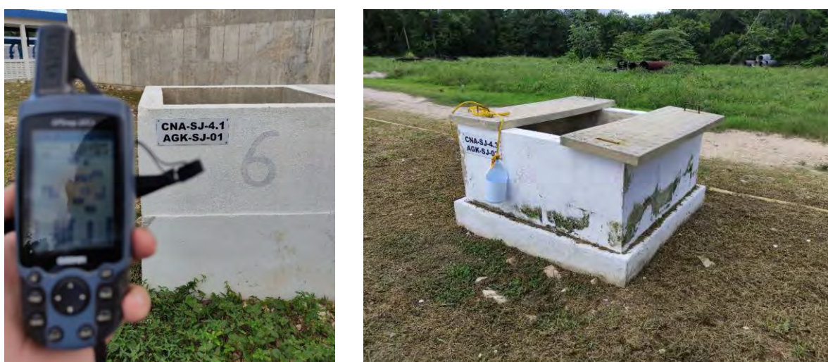
Figura 19 Pozos de infiltración PTAR Saas Tun Há
