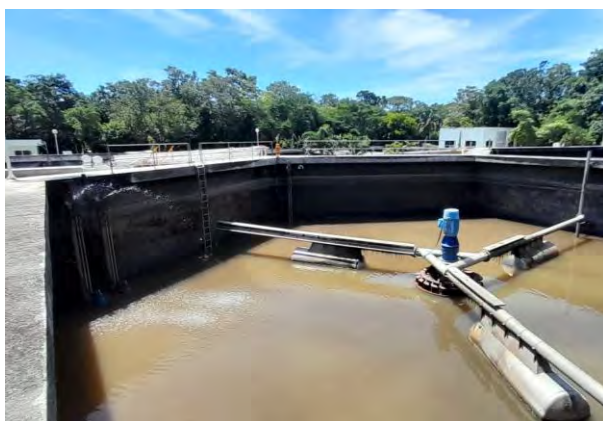
Figura 5 Reactores SBR 2a Etapa, Equipado y Sin Equipar
