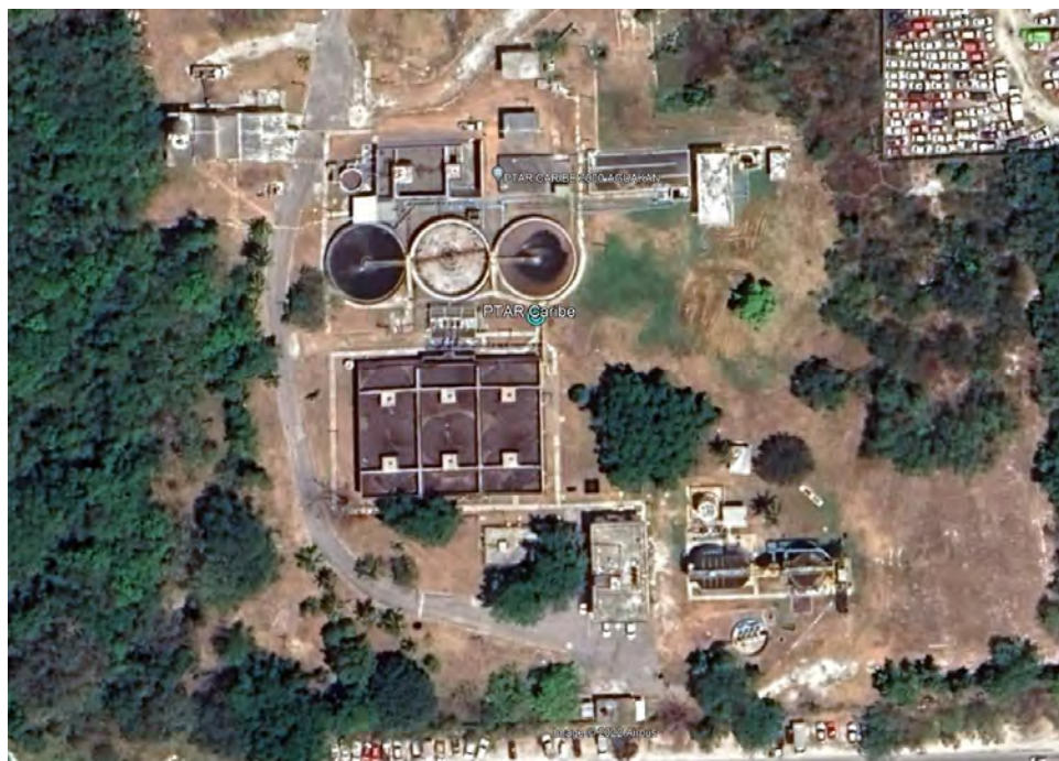
Figura 1 Vista Aérea PTAR Caribe
