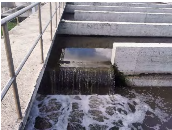
Figura 12 Tanque de contacto de cloro
