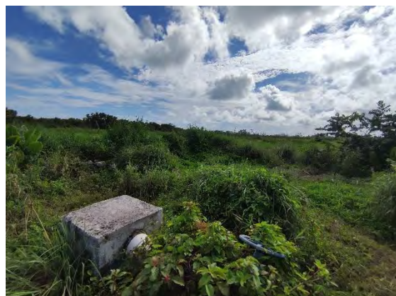
Figura 14 Pozo de infiltración cubierto de maleza
