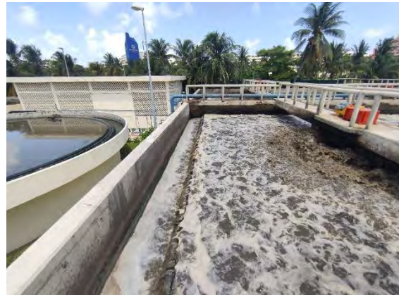
Figura 9 Reactor de Lodos Activados Aireación Superficial 1ª Etapa
