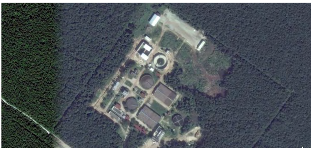
Figura 1 Vista Aérea PTAR Saas Tun Há
