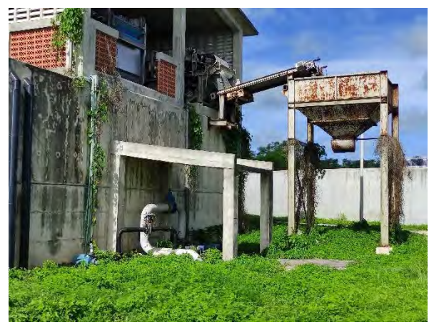
Figura 18 Aspecto de la planta alta de la caseta de desaguado de lodos con equipos fuera de operación.
