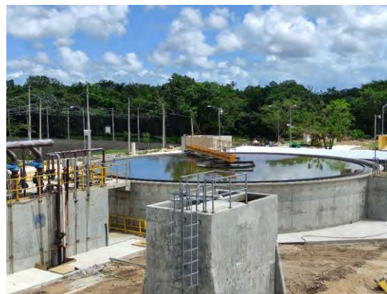
Figura 8 Clarificador secundario 2; clarificador secundario 1 y cárcamo de recirculación y purga de lodo
