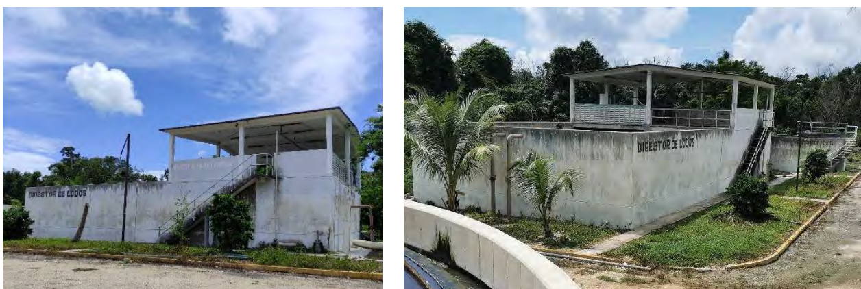
Figura 18 Edificio de manejo de lodos
