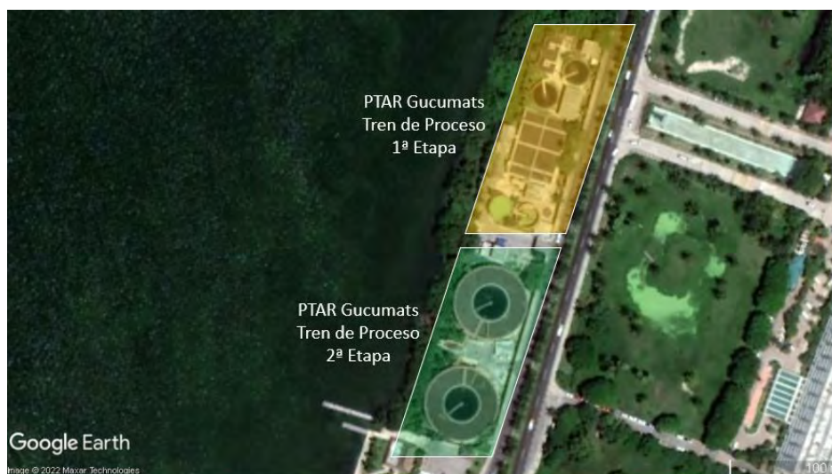
Figura 2 Vista Aérea partes de PTAR Gucumatz
