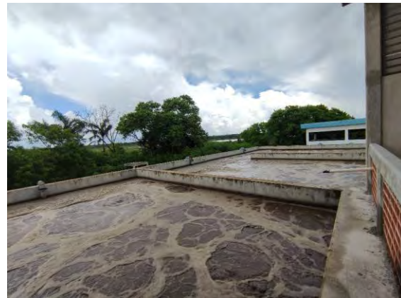
Figura 16 Digestor de lodos
