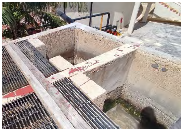
Figura 17 Desarenador Horizontal y Distribución a Reactores de Lodos activados 2ª Etapa
