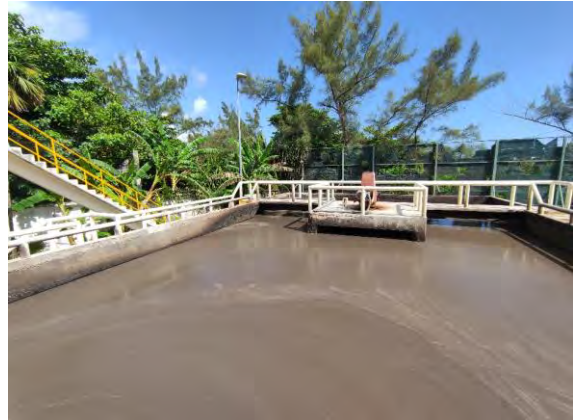
Figura 15 Digestor aerobio de lodos
