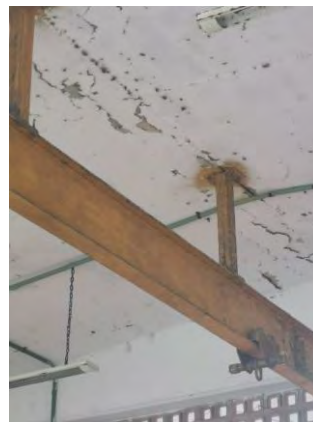
Figura 11 Caseta de dosificación de cloro y detalle de techo con grietas y desprendimiento de enjarre
