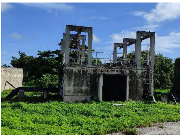
Figura 16 Cárcamo de recirculación de lodo y cárcamo de natas
