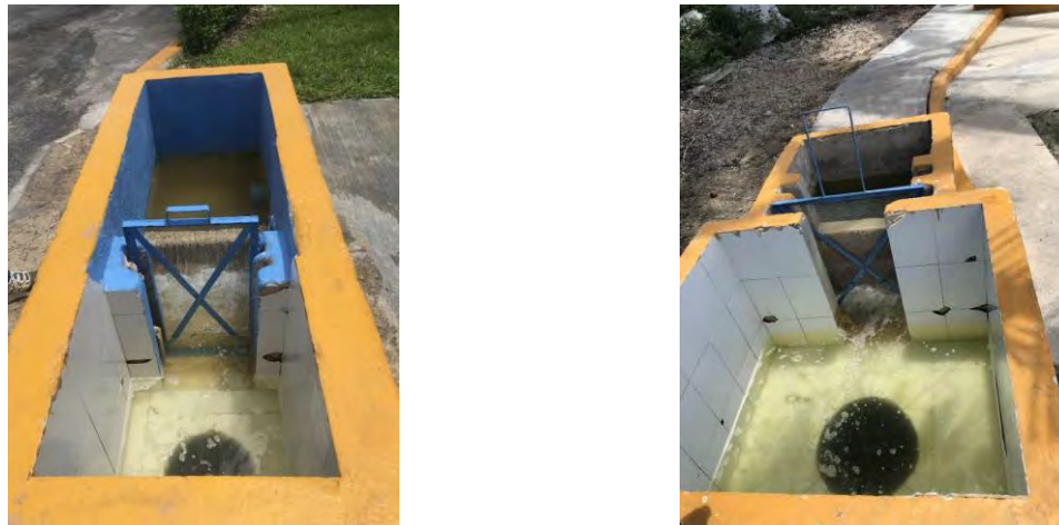
Figura 13 Pozo 2 de infiltración de agua tratada, y pozo 3 de infiltración de agua tratada
