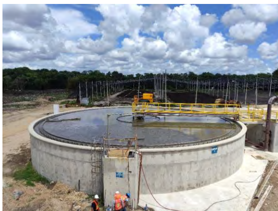
Figura 8 Clarificador secundario 2; clarificador secundario 1 y cárcamo de recirculación y purga de lodo
