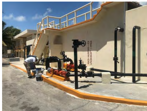
Figura 15 Digestor de lodo en fase de decantación y bombas de lodo digerido a desaguado
