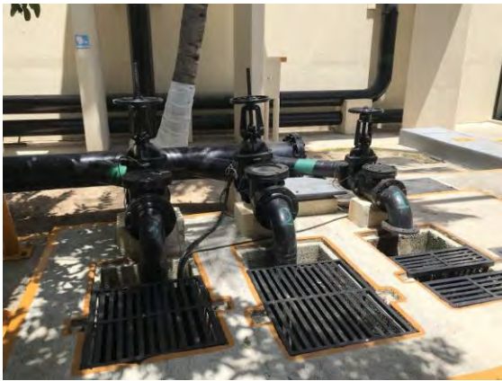
Figura 4 Cárcamo final de agua cruda y vista superior del desarenador
