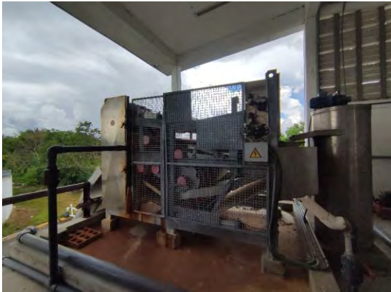
Figura 19 Filtro banda para desaguado y edificio de desaguado sobre digestor
