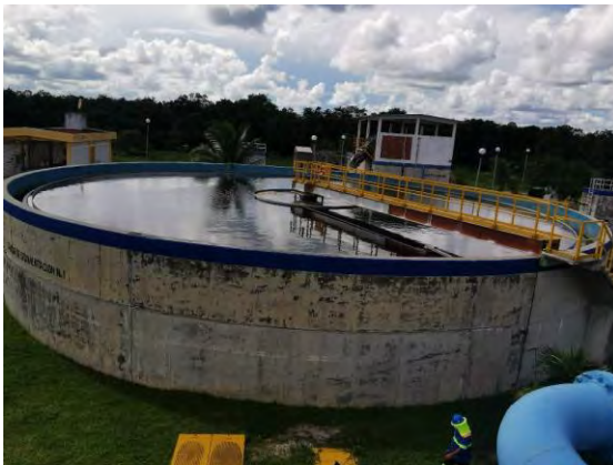
Figura 7 Clarificador Secundario y Caseta de Dosificación de Cloro
