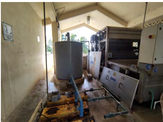
Figura 16 Caseta de Desaguado de Lodo, Preparador de Polímero y Filtro Banda en Operación de Desaguado
