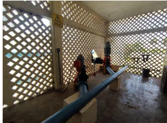
Figura 14 Pozo de infiltración de agua tratada y Bombas para Reúso 1ª Etapa
