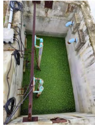
Figura 15 Detalle de instalación en cárcamo de recirculación de lodos (izquierda) y cárcamo de natas (derecha)
