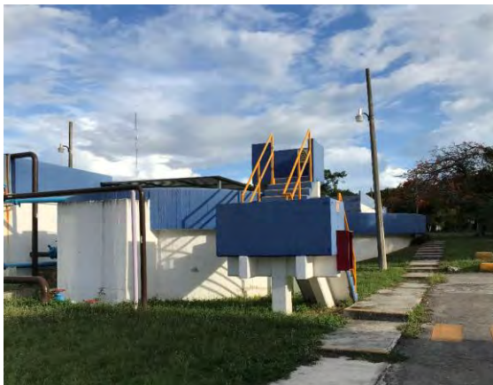
Figura 12 Espesador gravitacional de lodo; vista exterior del digestor aerobio de lodo
