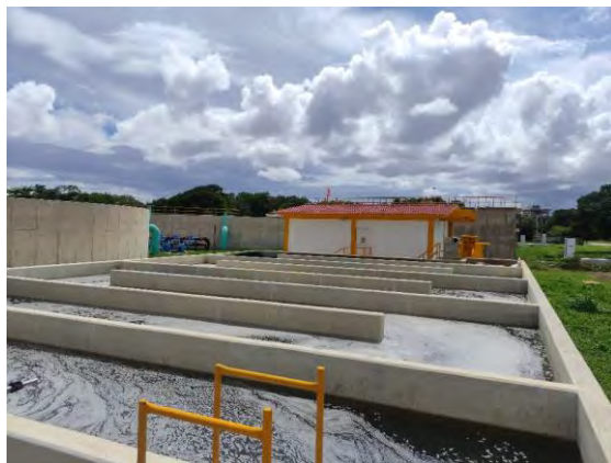
Figura 10 Tanque de Contacto de Cloro y Caseta de Dosificación de Cloro
