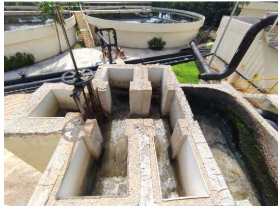
Figura 6 Canal Parshall y Caja Distribuidora de Agua Cruda
