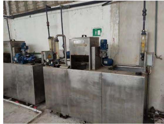
Figura 18 Filtro banda y preparador de polímero
