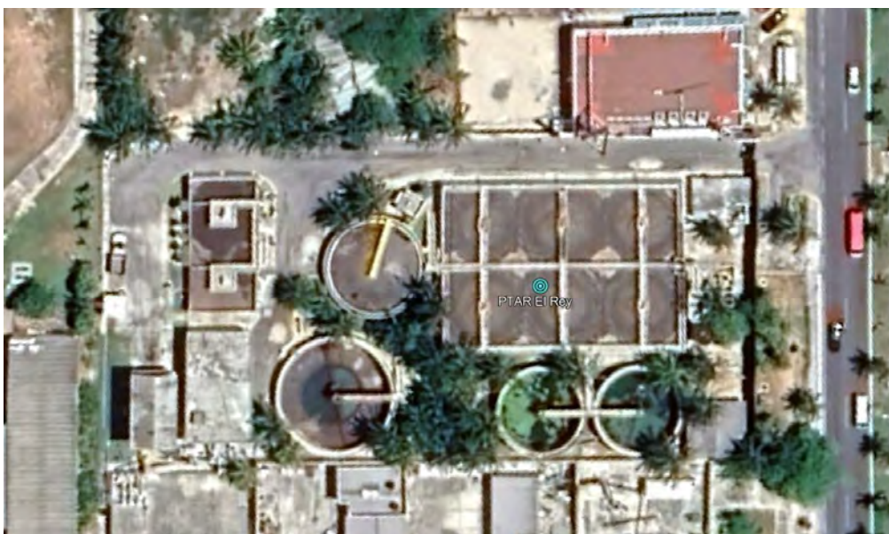
Figura 25 Vista actual de la PTAR El Rey
