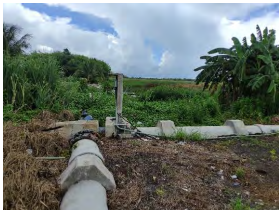
Figura 12 Detalle de medidor efluente, transductores y registro de caudal
