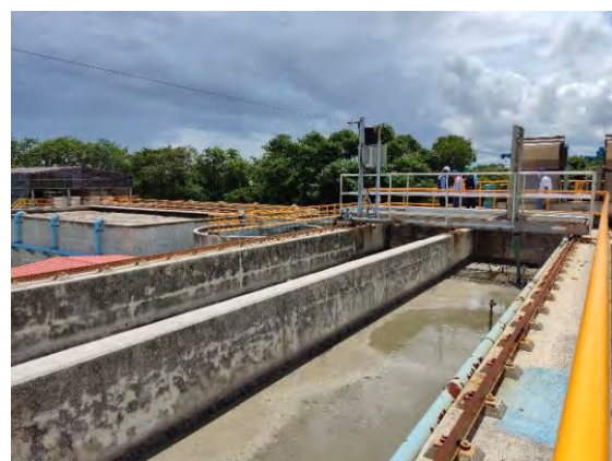
Figura 5 Canal Desarenador con Puente Móvil
