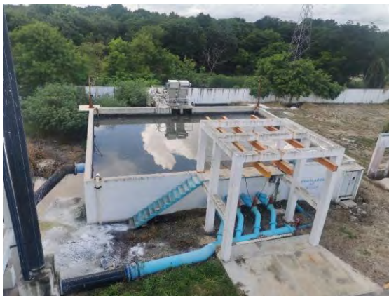
Figura 5 Estructura para izaje y bombas de tanque equalizador
