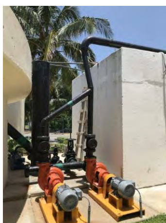
Figura 9 Bombas de recirculación y purga de lodo secundario, línea de recirculación de lodo a sección inicial del reactor
