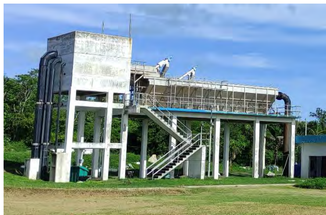
Figura 3 Cárcamo de recepción de pipas e ingreso de agua residual a plataforma de pretratamiento
