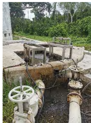
Figura 8 Filtro rociador con brazo distribuidor sin movimiento y cárcamo de elevación de agua de filtro rociador
