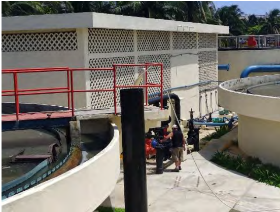
Figura 11 Tanque de Contacto de Cloro (Tapado) y Caseta de Dosificación de Cloro y Bombas de Agua de Servicios 1ª Etapa
