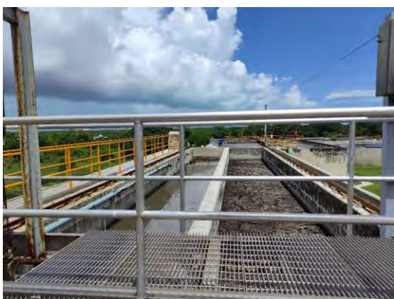
Figura 5 Canal Desarenador con Puente Móvil
