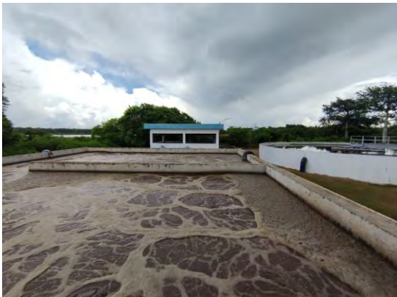
Figura 15 Detalle de instalación en cárcamo de recirculación de lodos (izquierda) y cárcamo de natas (derecha)
