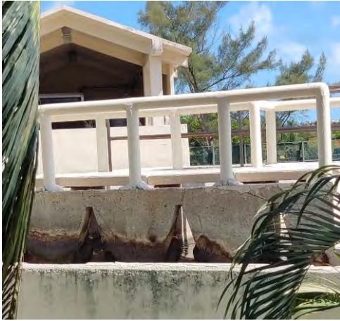
Figura 5 Vertedores en Desarenación Horizontal y Cribado Manual
