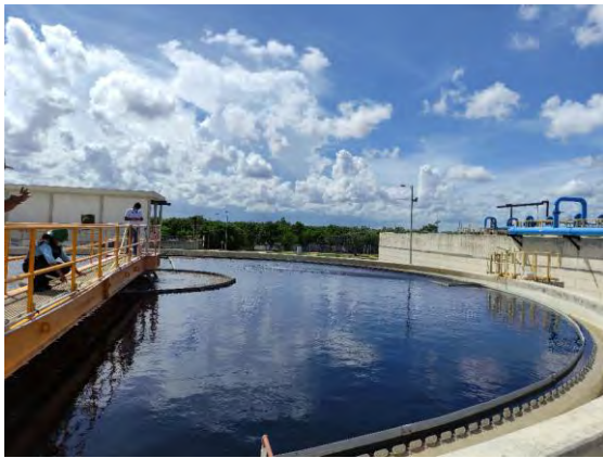
Figura 7 Reactor de Lodos Activados Zona Anóxica (Izquierda) y Zona Aerobia (Derecha)
