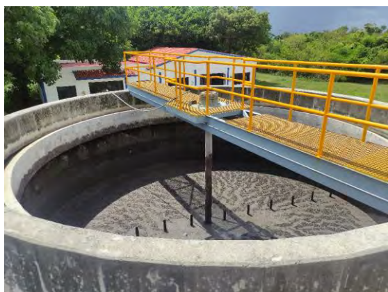
Figura 13 Tanque de Almacenamiento de Lodos y Filtro Banda
