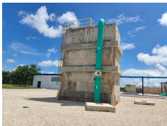
Figura 6 Cárcamo de Elevación de Filtro Rociador y Caja Distribuidora
