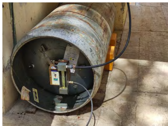
Figura 12 Tanques de Gas Cloro y Dosificador, Instalados a la Intemperie
