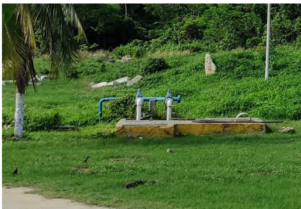
Figura 3 Cárcamo de recepción de pipas e ingreso de agua residual a plataforma de pretratamiento
