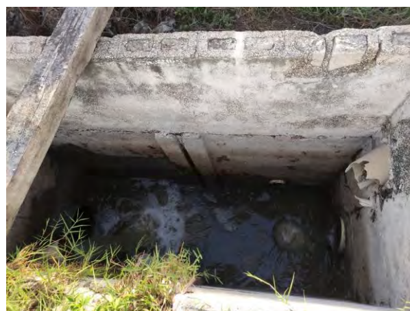
Figura 8 Agua tratada efluente del tanque de contacto de cloro; brocal de pozo de infiltración de agua tratada
