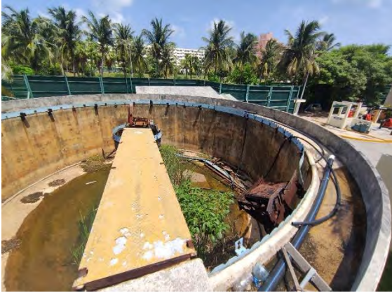
Figura 8 Sedimentador Primario fuera de operación 1ª Etapa
