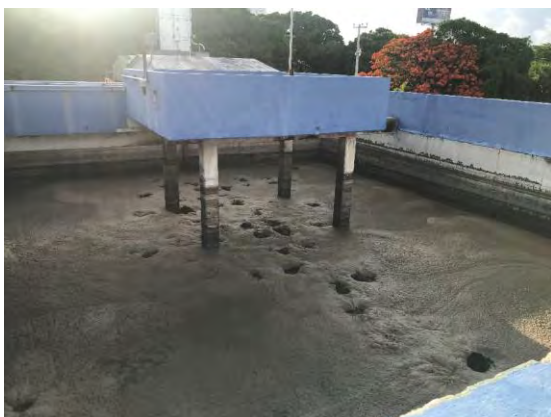
Figura 13 Vista interior del digestor aerobio de lodo; sopladores del digestor
