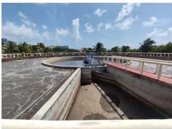
Figura 19 Reactor de Lodos Activados, Clarificador Secundario y Tanque de Purga de Lodos 2ª Etapa
