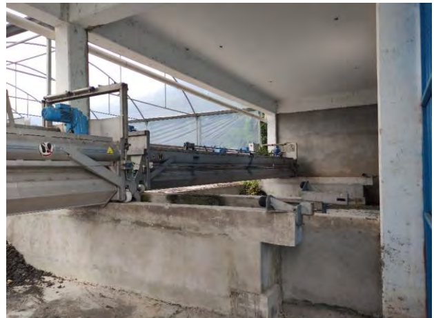
Figura 13 Invernadero para Secado de Lodos y Volteador de Lodos
