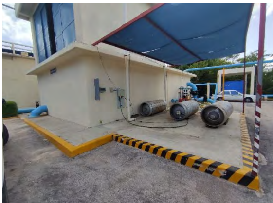
Figura 20 Tanque de Contacto de Cloro y Bombas de Agua de Servicio 2ª Etapa
