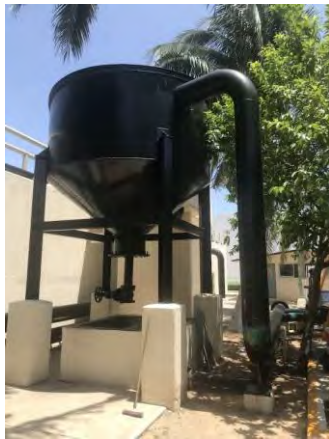
Figura 5 Desarenador y canal de medición de caudal y de cribado medio de limpieza manual
