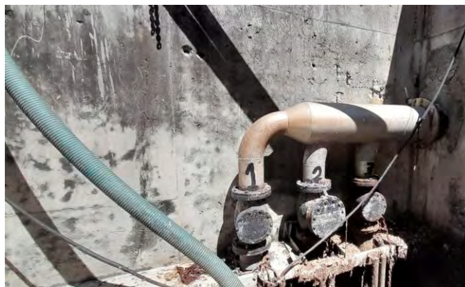
Figura 3 Cribado grueso manual y cárcamo de agua pretratada
