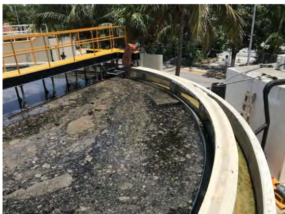
Figura 10 Clarificador secundario 1 y clarificador secundario 2, fuera de operación
