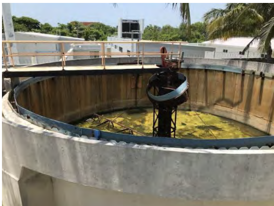
Figura 6 Sedimentador primario y bombas de lodos primarios
