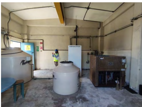
Figura 21 Sistema de Generación de Hipoclorito In Situ 2ª Etapa
