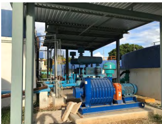
Figura 13 Vista interior del digestor aerobio de lodo; sopladores del digestor
