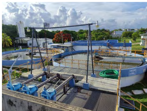
Figura 6 Clarificador secundario 2 y 3, cárcamo de recirculación y purga de lodo; agua clarificada efluente
