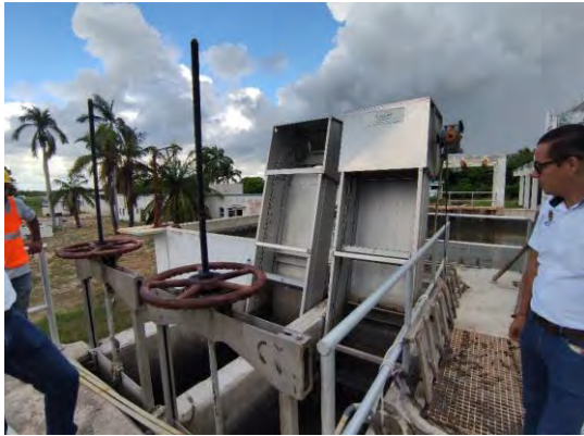
Figura 4 Cribado automático (fuera de servicio) y tanque de homogeneización
