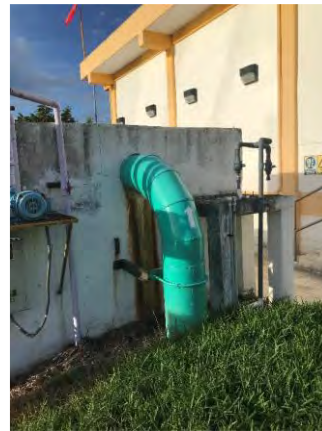
Figura 11 Bombas de recirculación y purga de lodo químico; línea efluente del TPQ a tanque de contacto de cloro
