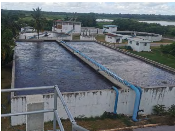
Figura 8 Reactor de lodos activados y vista general a plataforma de pretratamiento con equipo Ro 5 y cribado
