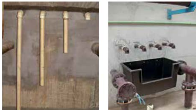
Figura 19. Ejemplo de un sistema de toma muestras de lodos en un reactor UASB. (Chernicharo, y otros, 2018)
