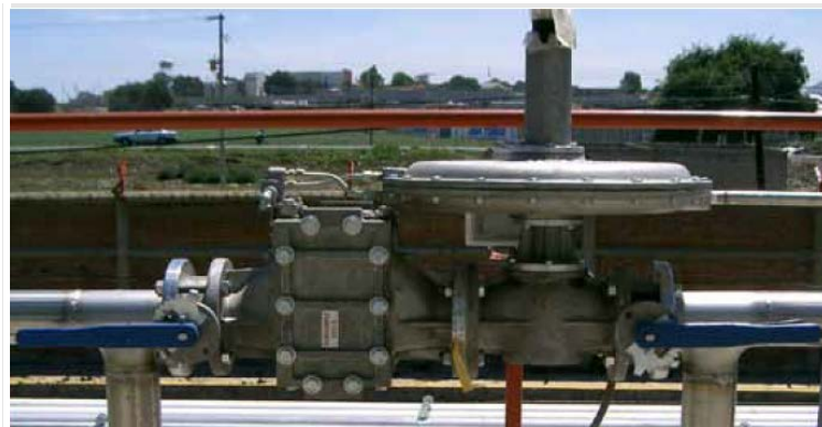
Figura 30. Ejemplo esquemático de arrestaflama vertical, válvula reguladora de presión y arrestaflama horizontal (Programa Aprovechamiento Energético de Residuos Urbanos en México, 2017)
