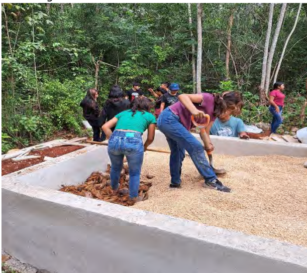
Figura 98. Acomodo de las capas de fibra de coco y gravilla.
