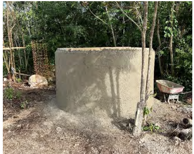
Figuras 57 a 59. Proceso de construcción de la base, paredes y sistema de limpieza y cosecha de agua de las cisternas.
