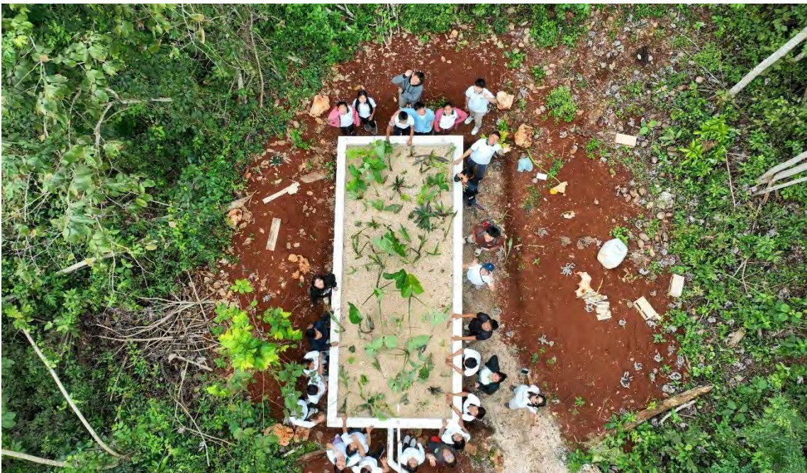
Figuras 119 a 121. Contenedor de sólidos y humedal artificial habilitado.
