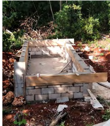
Figuras 53 y 54. Proceso constructivo del humedal artificial.
