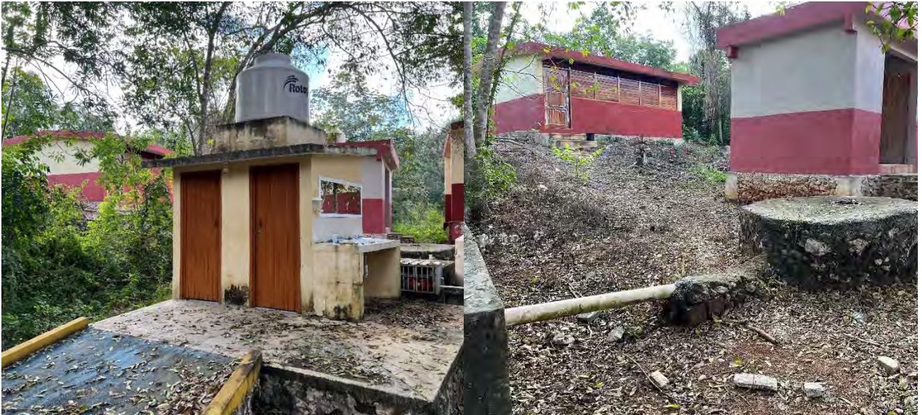
Figuras 131 y 132. Rehabilitación sanitaria realizada.
