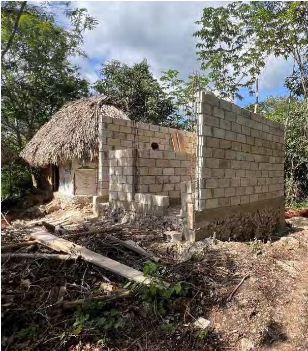
Figuras 47 y 48. Construcción de paredes y techo de los Sanitarios ecológicos.
