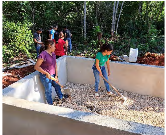
Figura 97. Colocación de la capa de grava.
