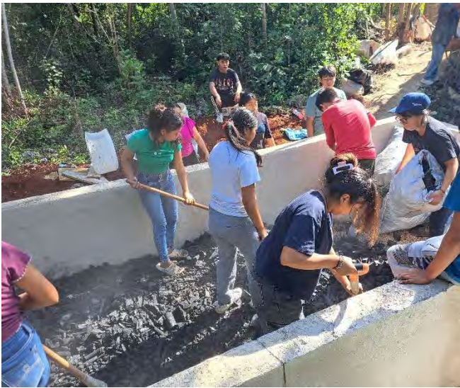
Figura 96. Llenado del humedal con carbón.
