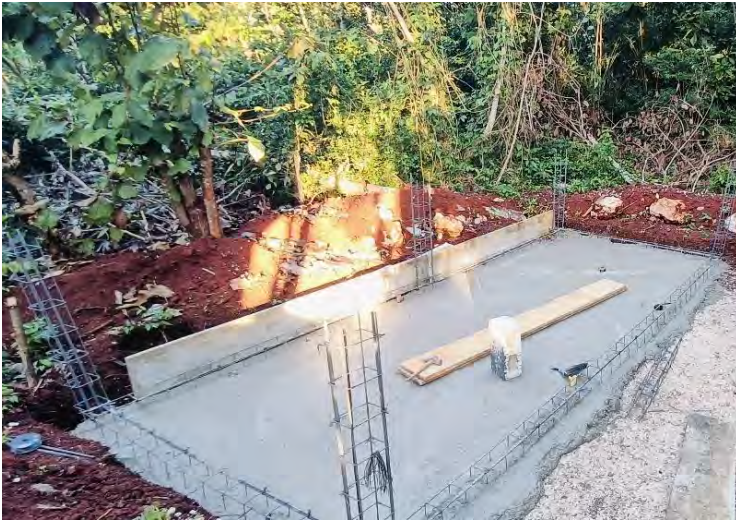
Figuras 53 y 54. Proceso constructivo del humedal artificial.
