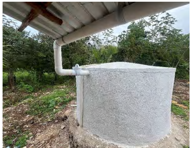
Figuras 62 y 63. Líneas de conducción del SCALL instalado en los salones.
