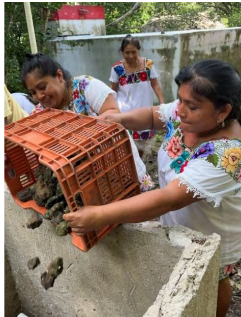
Figura 78. Llenado de la primera capa de sustrato (rocas).
