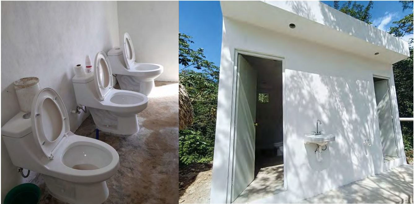
Figuras 49 y 50. Acabados interiores y exteriores de los Sanitarios ecológicos.
