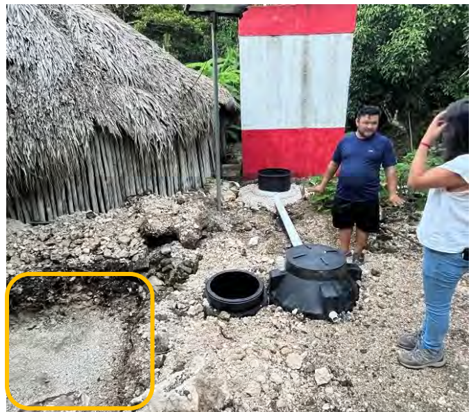
Figura 38. Ubicación de humedal artificial respecto a la pendiente del terreno.
