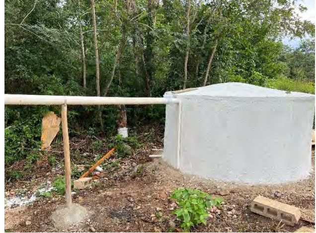
Figuras 64 y 65. Líneas de conducción del SCALL instalado en los sanitarios.
