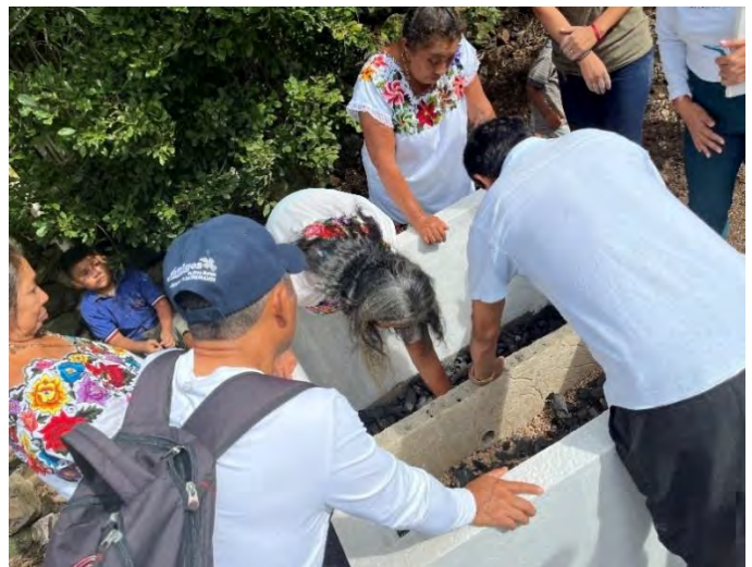
Figura 80. Vertido de carbón.
