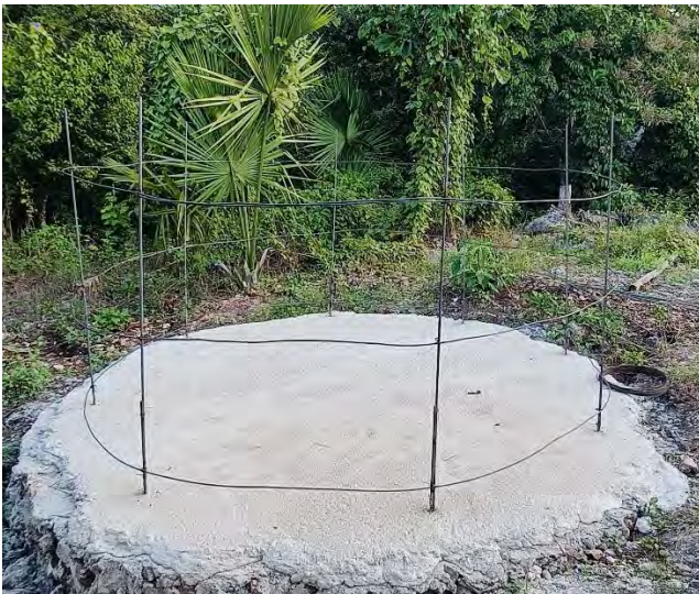
Figuras 57 a 59. Proceso de construcción de la base, paredes y sistema de limpieza y cosecha de agua de las cisternas.
