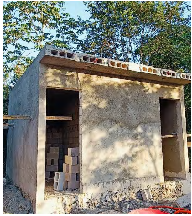
Figuras 47 y 48. Construcción de paredes y techo de los Sanitarios ecológicos.
