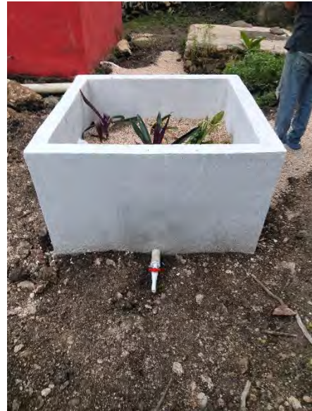
Figura 84. Vista frontal del humedal.
