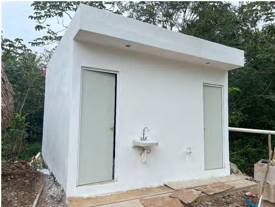
Figura 118. Sanitarios ecológicos para dama y caballero.
