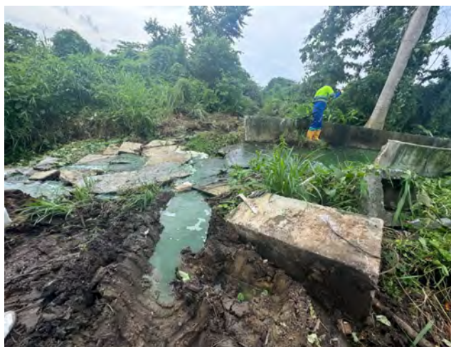
Figura 1b. Vertimiento del STAR al drenaje natural
