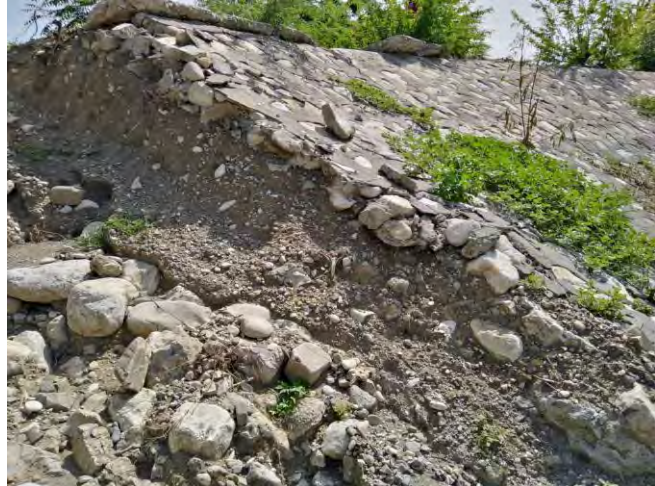
Tipo de construcción del sistema lagunar utilizado para la protección de taludes
