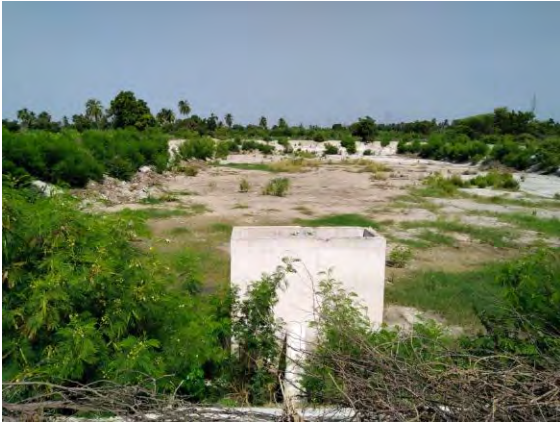
Estado de la Laguna 2 del sistema de tratamiento.
