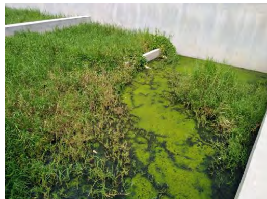
Filtros FAFA sin losa superior
