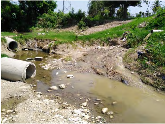
Punto de descarga de aguas residuales del alcantarillado de Sabana Yegua previo a la llegada del sistema de tratamiento (Arrovo Copev)
