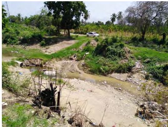
Punto de acceso a la planta de tratamiento de aguas residuales
