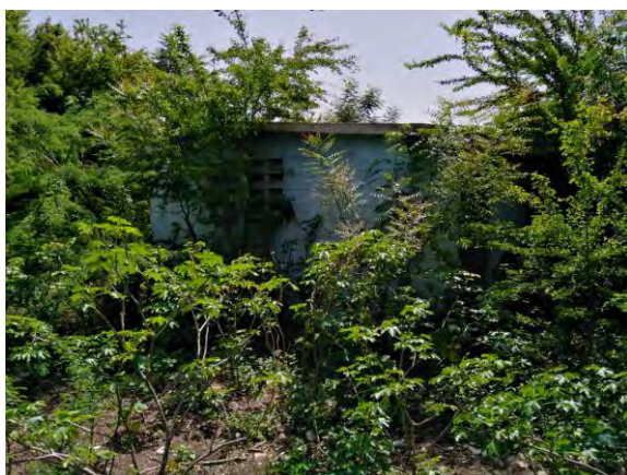
Estado de la caseta de operador del sistema de tratamiento.
