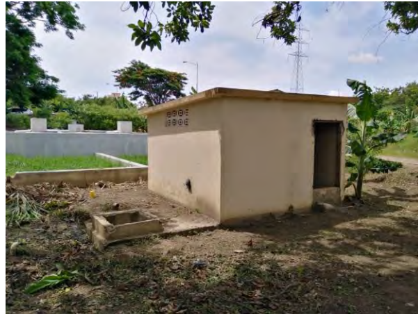
Caseta de bombeo del agua tratada
