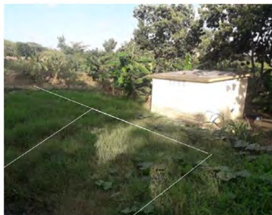
Crecimiento incontrolado de vegetación en los FAFA de la planta de tratamiento
