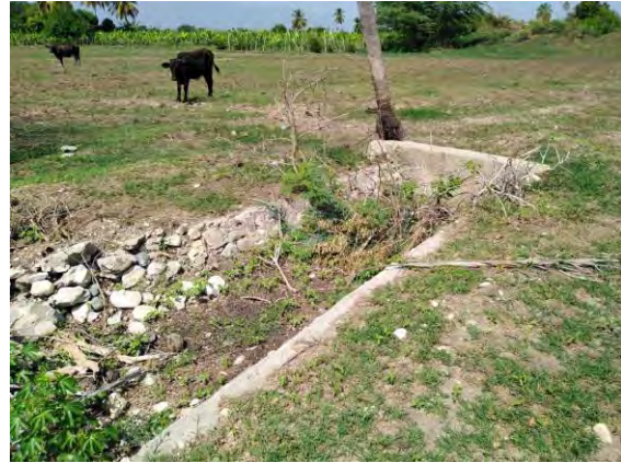
Punto de desfogue de las aguas de la laguna 2 hacia la propiedad colindante.
