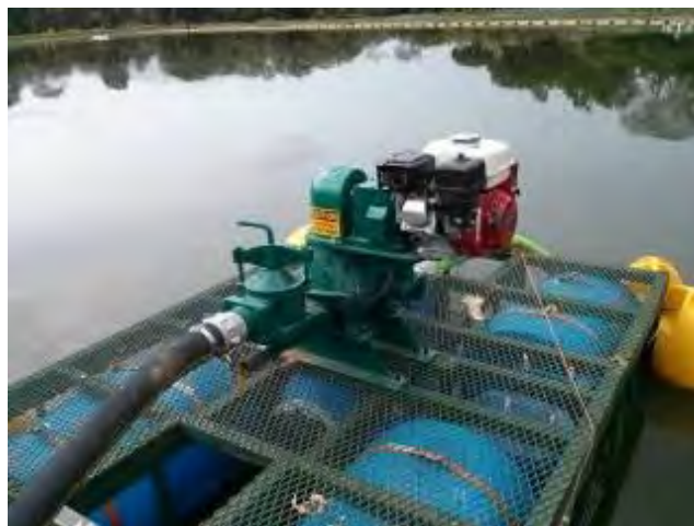
Bomba de desplazamiento positivo montada en balsa para extracción de lodos por vía húmeda
