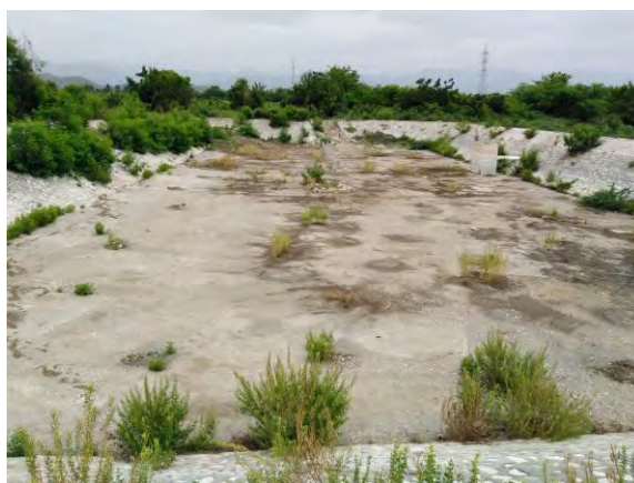
Estado de la Laguna 1 del sistema de tratamiento.
