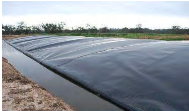
Vista de una laguna anaeróbica cubierta (M,usa y Idrus, 2021)
